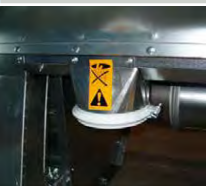
Apertura di ispezione sul fondo della tramoggia.
