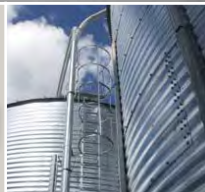
Assemblaggio dei tubi per riempire silos esterni.
