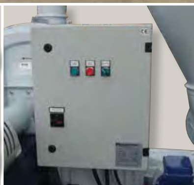
Cabina di controllo per accensione/spagnimento automatico del motore.
