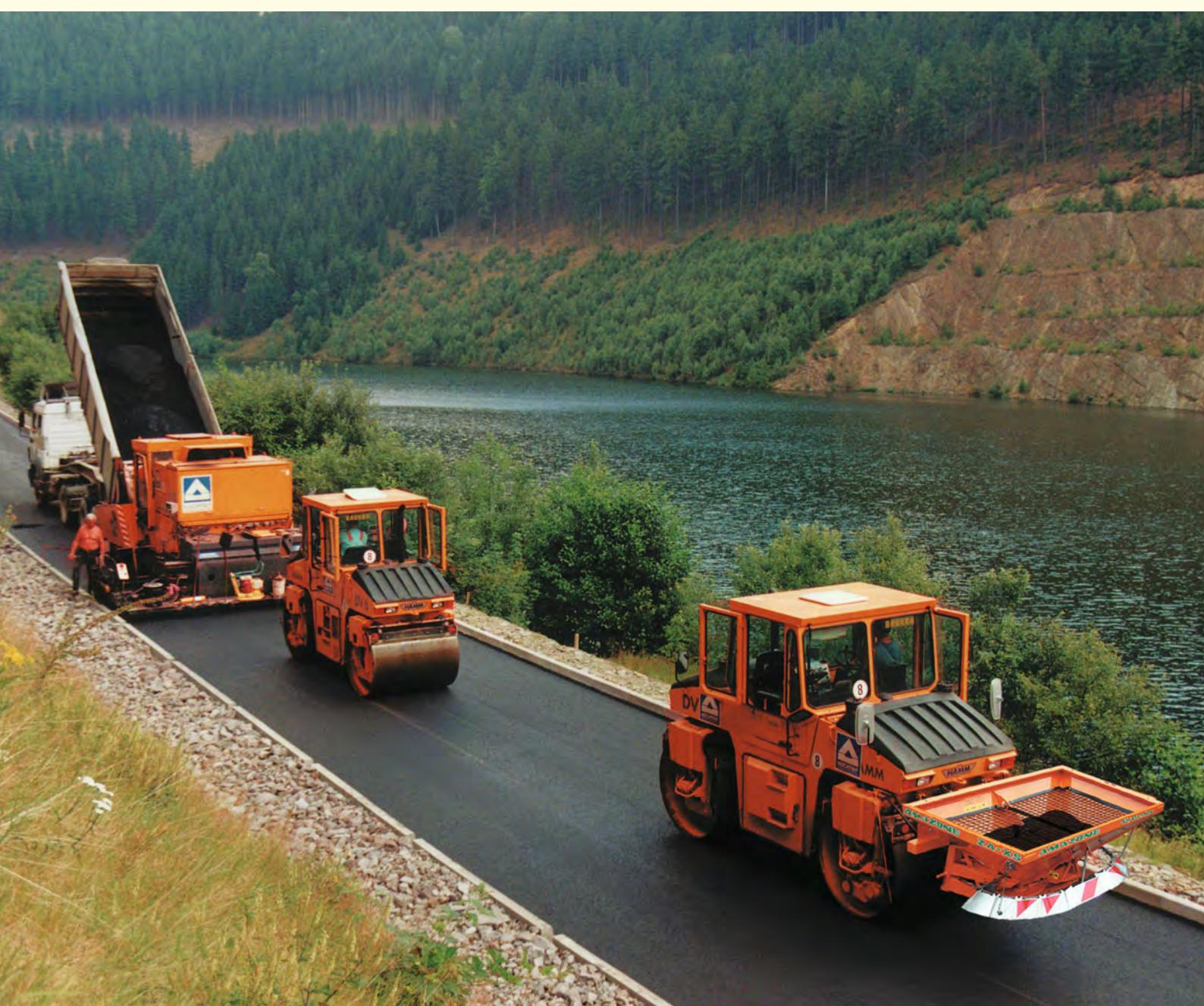
Lo spargitore ZA-XS H è progettato appositamente per la cantieristica stradale. Grazie al suo azionamento idraulico, lo spargitore a due dischi è perfetto per i rulli stradali che comprimono l'asfalto e contemporaneamente distribuiscono materiale sabbioso. La stabile struttura dello ZA-XS H, assicura inoltre una lunga durata.
